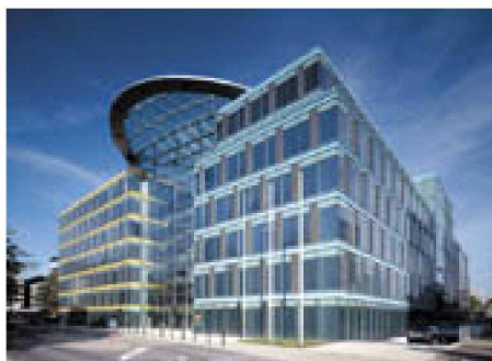
Spherion - Düsseldorf, Alemanha Arquitectos: Deilmann & Koch Architekten Stadtplaner
